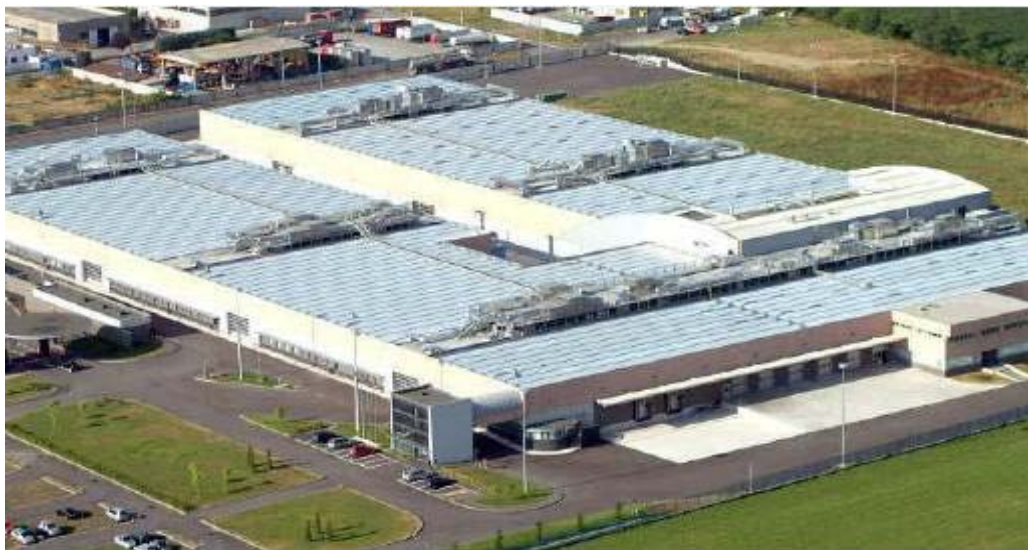
Una veduta aerea dello stabilimento della Intercos in territorio di Dovera
