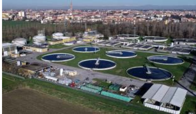
In questa e nella foto a destra impianti di Padania Acque
